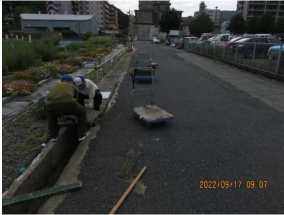
側溝に溝蓋をつくり道路を安全に
