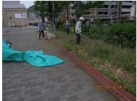
「美術館駅」の除草作業
