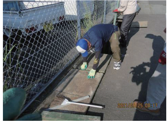
壊れた側溝の蓋を修理
