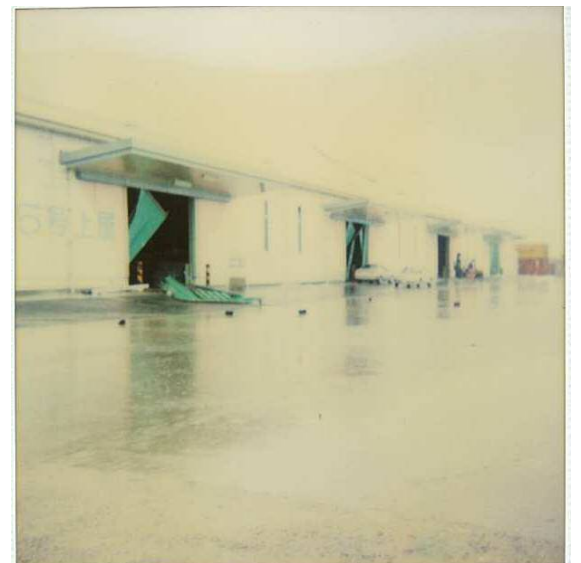
④上屋の破損(太刀浦5号上屋)
