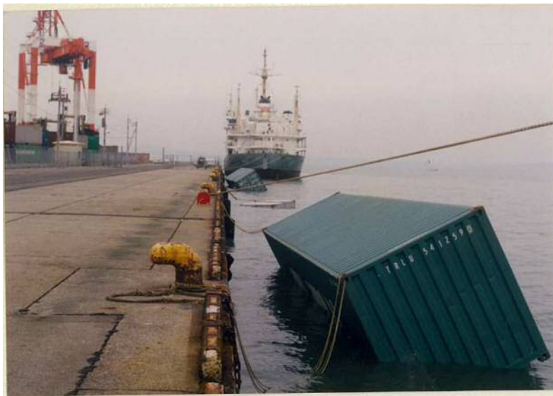
②流出したコンテナ(太刀浦9号岸壁)
