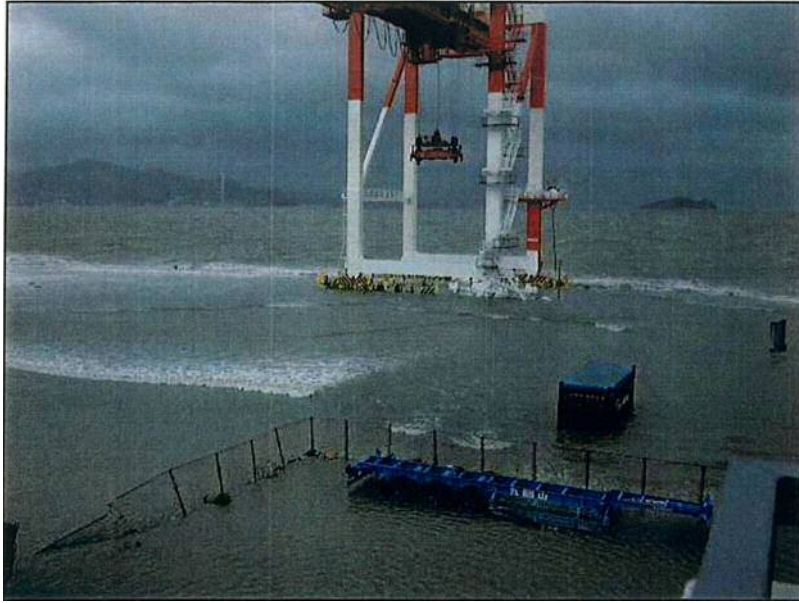
①ガントリークレーンの浸水 (太刀浦第2コンテナターミナル)
