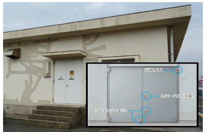
(受電所の扉を防水扉へ改良)
