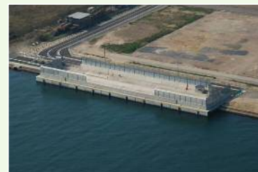
響灘リサイクルポート岸壁
