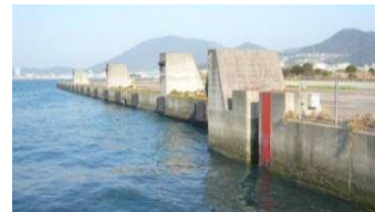
図 2-18 耐震強化岸壁の整備(砂津地区)
