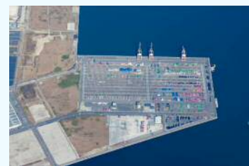
ひびきコンテナターミナル
