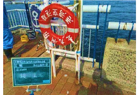
【救命浮環取付台補修工事】
