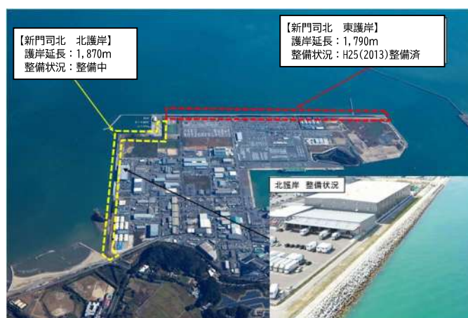
図3 高潮対策実施事例（新門司北地区）
