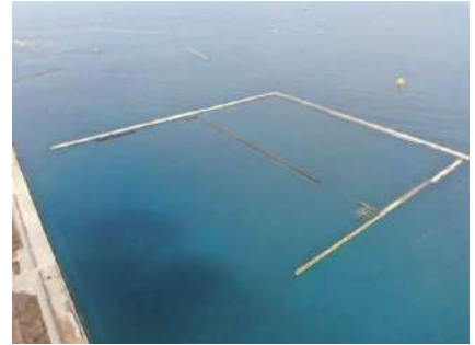
整備中の新処分場(響灘東地区)
