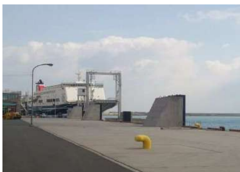
図2 新門司南地区耐震強化岸壁
