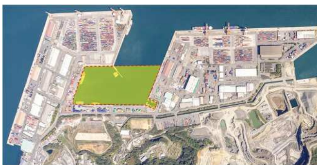
【太刀浦地区施設整備調査検討箇所】
