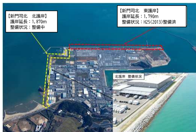
図3 高潮対策実施事例（新門司北地区）
