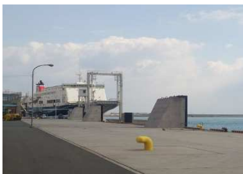
図2 新門司南地区耐震強化岸壁
