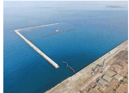
整備中の新処分場(響灘東地区)
