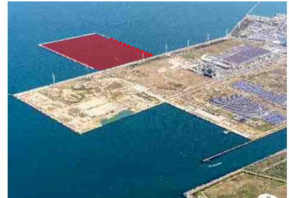
処分場整備箇所
