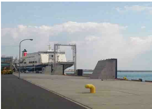
図 2 新門司南地区耐震強化岸壁
