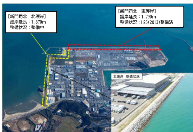
図 3 高潮対策実施事例（新門司北地区）
