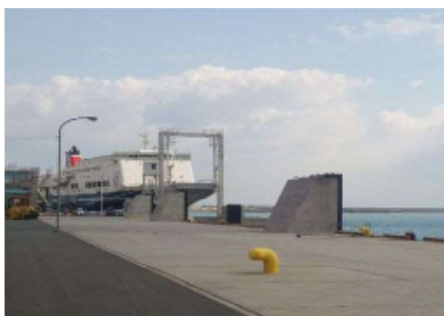
図 2 新門司南地区耐震強化岸壁
